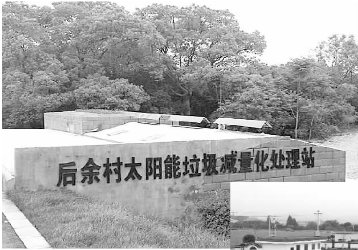
上图:浙江金华市金东区澧浦镇垃圾处理中心。
