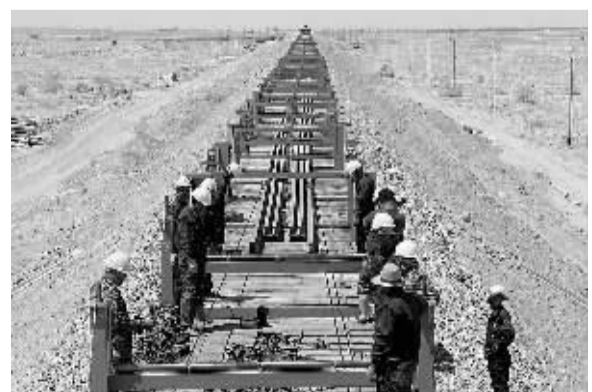
5月3日,中铁九局工程人员在额哈铁路新疆哈密段铺设钢轨。额(济纳)哈(密)铁路东起临策铁路川地托站,经内蒙古自治区额济纳旗、甘肃省肃北县,终至兰新铁路新疆哈密东站,正线长度629.9公里。蔡增乐摄(新华社发)
