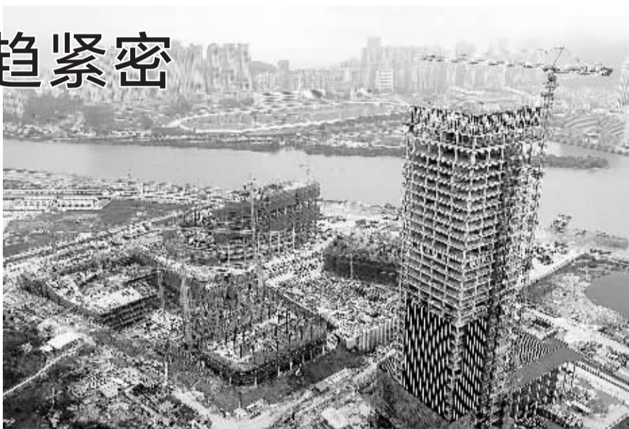
建设中的广东自贸区珠海横琴新区片区，澳门与其仅一水之隔。 新华社记者 刘大伟摄
