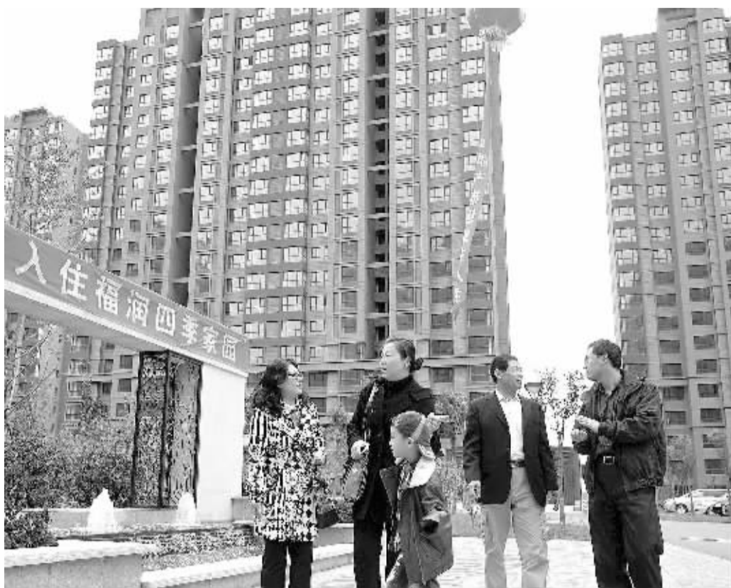
日前,工作人员为首批拿到北京城建福润四季项目保障房钥匙的居民介绍小区环境。北京朝阳区东坝乡城建福润四季项目总占地面积近16万平方米,总建筑面积约35万平方米,是北京最大规模保障房项目之一,能够容纳3500多户低收入家庭入住。 本报记者 赵晶摄
