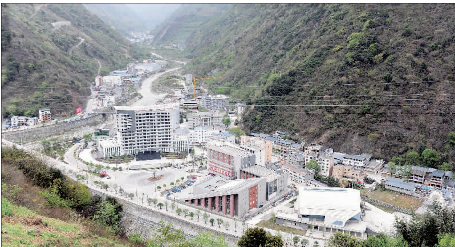
雅安市宝兴县雪山村，一座座新建筑拔地而起。经过两年的恢复重建，这里焕然一新。
