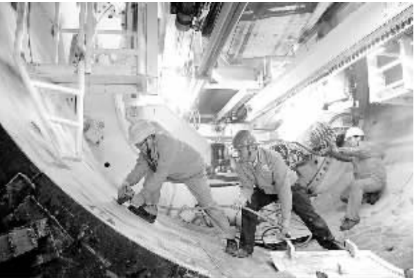
4月16日,由中铁隧道集团负责施工的青岛地铁2号线一标段实现硬岩掘进机顺利始发。这是我国首次将该施工技术运用于地铁建设,可以有效降低爆破产生的噪音,减少施工粉尘,同时降低安全风险。图为施工现场工人在做硬岩掘进机始发前的准备。 本报记者 赵晶摄
