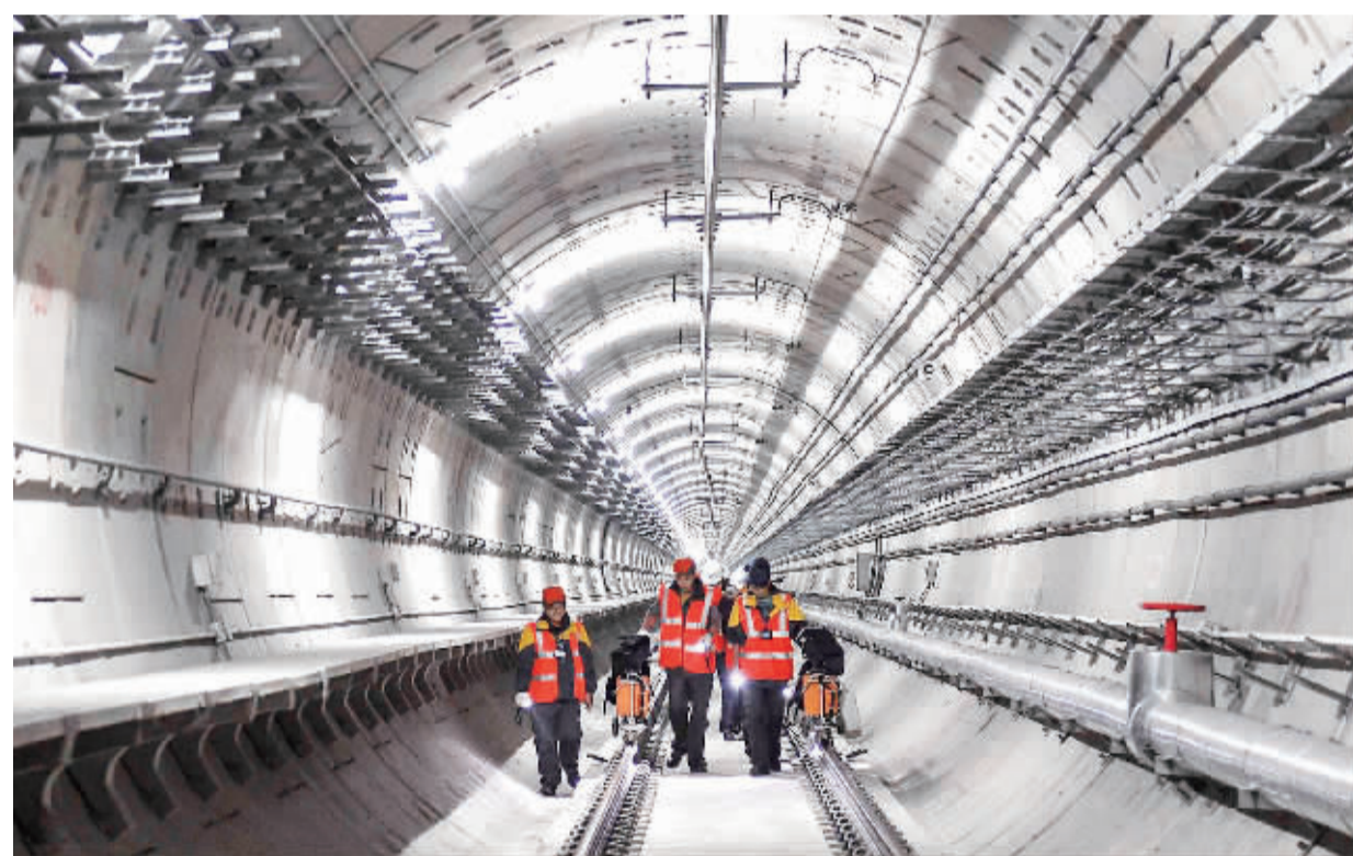
探伤工作 地铁 探伤工 在北京地铁四号线某段隧道内进行钢轨母材探伤工作 新华社记者 罗晓光 摄
