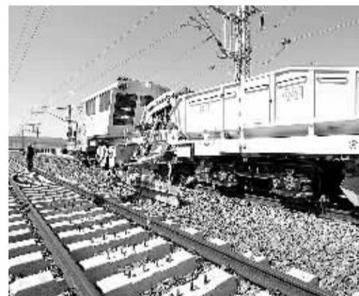
4月7日,在哈(尔滨)绥(芬河)铁路牡丹江至绥芬河铁路扩能改造工程现场,专业车辆在平整轨道砾石。该工程按照国家一级、双线电气化铁路标准设计,速度目标值为200公里/小时。
