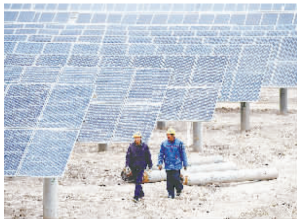
目前，在河南兰考县谷营乡黄河滩区，已建成200MW光伏电站，预计年发电量约2.6亿千瓦时。图为河南兰考县谷营乡黄河滩区建成的光伏电站。
