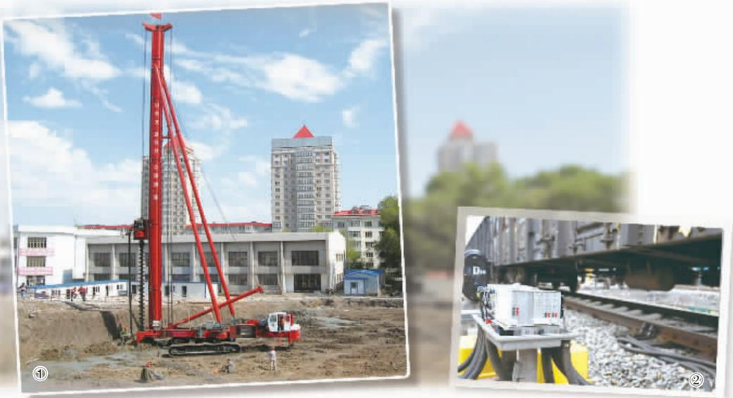
图① 黑龙江省建设集团、黑龙江省建工集团自主研发的“钻孔压灌超流态混凝土扩底桩施工技术”,采用长螺旋钻机钻至设计深度后再利用专用装置搅拌扩底,使其承载力及抗拔力大大提高。该集团借助院士工作站及博士后工作站平台,着力实施自主创新,获得专利授权120多项,形成了节能省地环保型承重墙体系成套技术。
