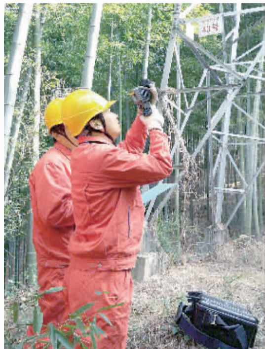
2月20日，国家电网浙江余姚市供电公司梁弄供电所检修人员用仪器测量电塔数据。本报记者 杨开新摄
