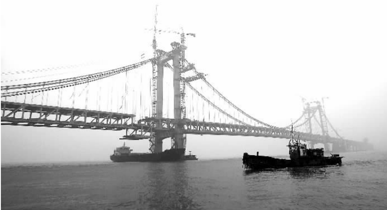
日前，全长约6公里的大连南部滨海大道跨海大桥即大连星海湾跨海大桥合龙。
