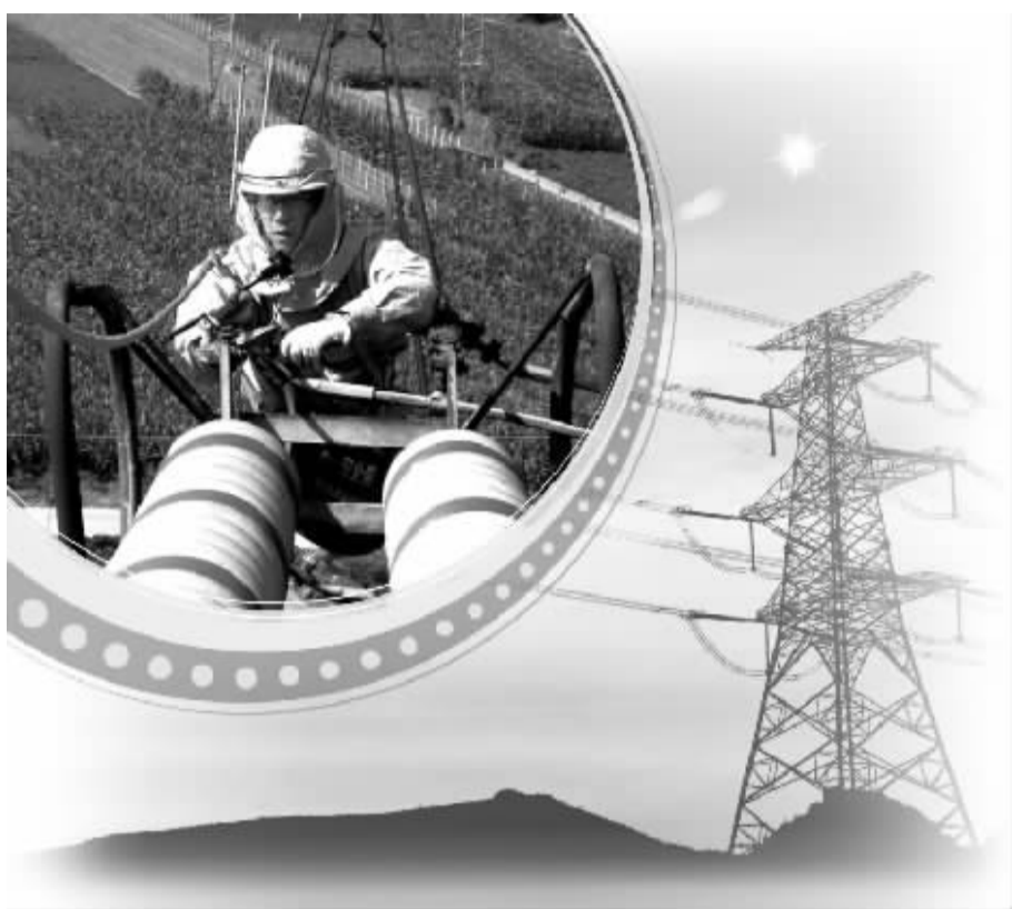
为保证电网迎峰度夏,王进在40摄氏度高温下开展500千伏邹川线带电作业。张金财摄
