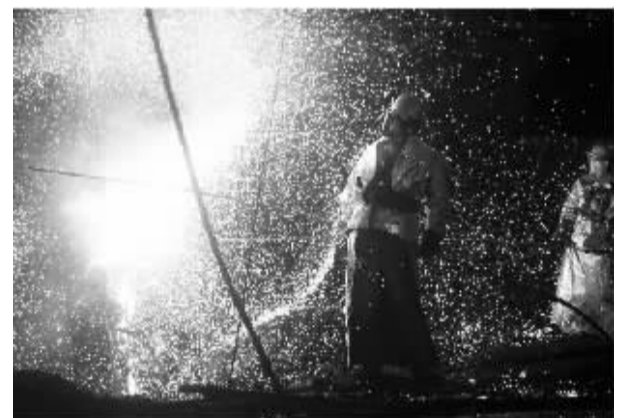
《建设者风采》 点火! 宝钢三号高炉大修工程成功点火投产。沈有福摄
