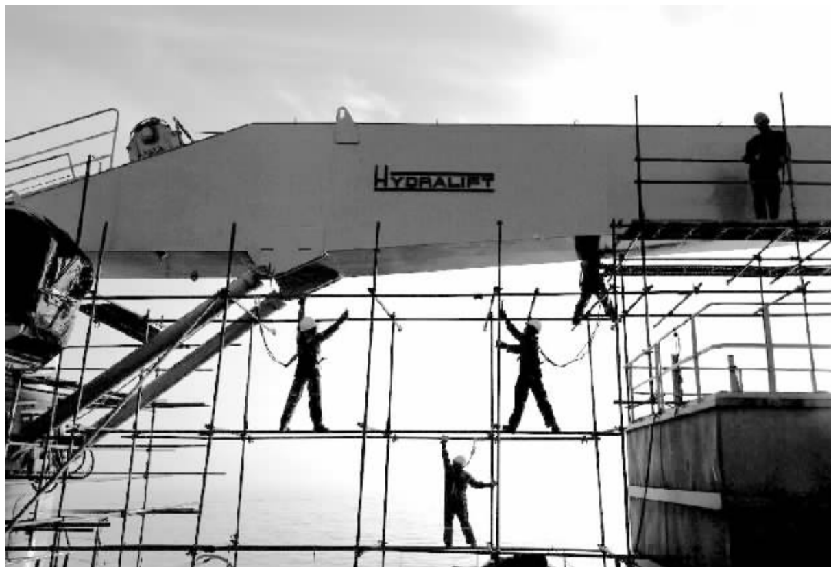
《海上彩绘师》 在余晖映衬下,中国海油油漆工正在为“海洋石油102”FPSO(海上浮式生产储卸油装置)的吊车表面进行“美容”作业。杜鹤辉摄
