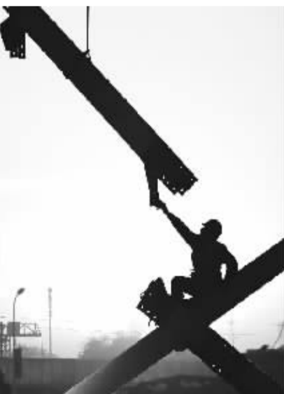
《迎接》 北京电力建设公司承建的神华国华(北京)燃气热电工程正在进行主厂房钢架吊装。夕阳斜下,作业员工在钢架上迎接着缓缓下落的钢梁。苏柏清摄
