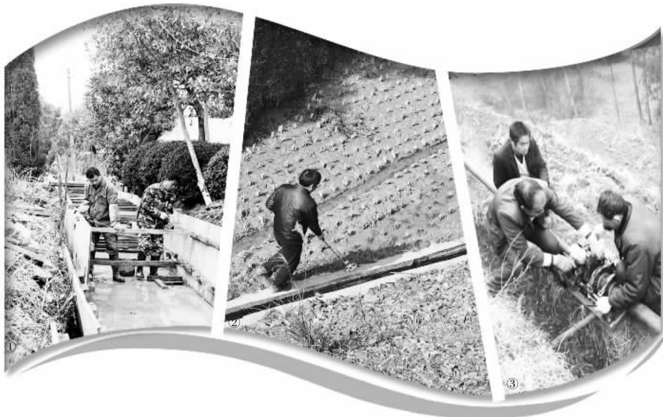
① 1月14日,江西省大余县“小农水”工程南安镇灌区建设现场,工人们正在安装模板、浇筑水渠。 ② 近年来,贵州省锦屏县河口乡重点推进农田水利工程建设,为山区群众解决水源问题。 ③ 1月15日,云南省宣威市文兴乡水务管理所施工队,正带领佃户村民铺设和安装主引水管网。
