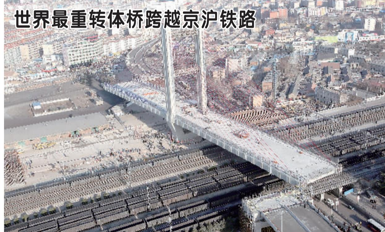
本报济南1月19日电 记者郭存报道:由中国中铁大桥局承建的世界最重转体桥——山东省邹城市30米上跨铁路立交桥,今天下午历时99分钟,在整体旋转97.3°后,成功跨越京沪铁路。这一过程该桥转体长度达198米,转体重量达2.24万吨,刷新了比利时的本·艾因桥1.96
