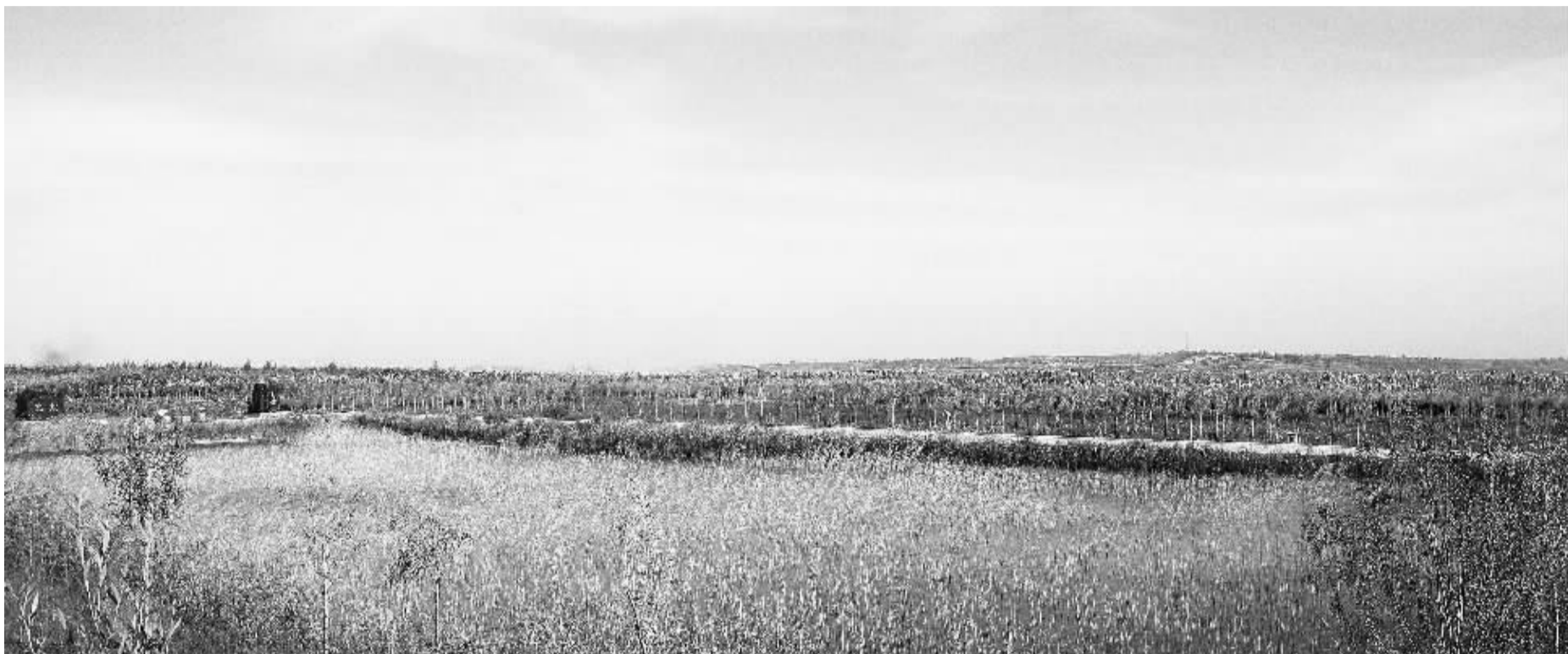
武家塔煤矿抽取采坑内的污水,经沉淀后用于绿化。图为沉淀池。
