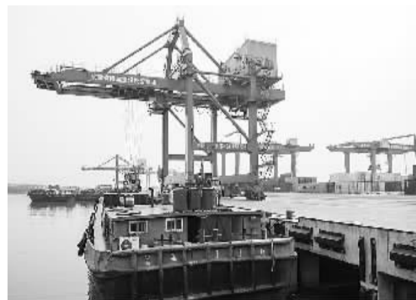
1月7日，船舶停靠在合肥港国际集装箱码头。当日，合肥港国际集装箱码头二期工程交付使用，意味着该港每年可满足60万标箱的集装箱吞吐需求，并以总占地1134亩的规模，成为全国面积最大的综合性内河港口。
