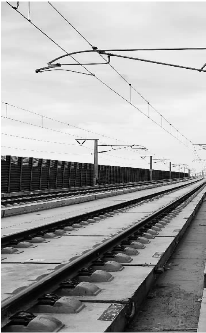
兰新高铁新疆段穿越的是举世闻名的内陆四大戈壁风区,风最大时,时速60米/秒。兰新高铁的防风工程建设规模在世界高速铁路中位居首位,通过路基挡风墙、桥梁挡风屏、防风明洞等三类主要防风结构和沿线的隧道、渡槽明洞及深路堑等兼顾防风工程,将大风的影响降低到最低程度。(资料图片)
