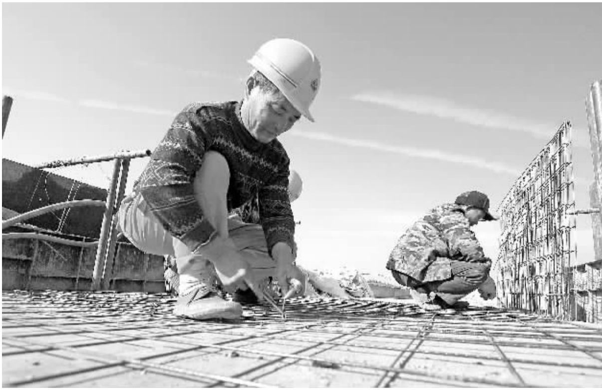
1月3日,江西广昌县船顶隘(赣闽界)至广昌高速公路施工现场,工人们正在加班加点进行路基土石方和涵洞工程施工。该项目建成后,将成为赣东赣南地区通向长三角经济发达省份的快捷通道。 言午摄
