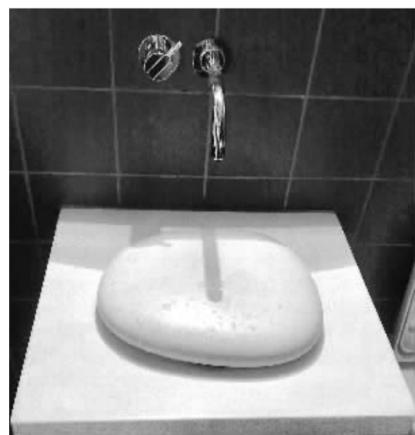
丹麦哥本哈根一家旅馆中的节水洗手池。
