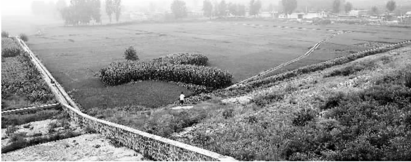
全长52.3公里的主干渠和308公里的支渠、331公里的斗渠,串珠走线般连起了百座以上水库及众多坑塘,打通了到田间地头的“最后一公里”,使农业生产条件得到极大改善。图为黄家村水稻灌溉渠。 刘学忠 董小琳 摄
