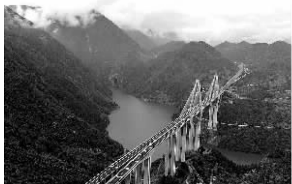
11月25日拍摄的宜巴高速公路神农架大桥。宜巴高速公路为沪蓉高速公路中的一段，全程共有138座桥梁，39座隧道，被誉为“桥隧博物馆”。
