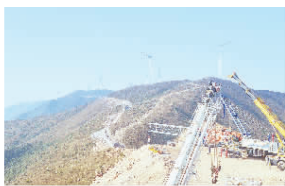
11月20日,施工人员在江西省于都县屏山风力发电场吊装风力发电机组。据了解,该项目共安装24台单机容量为2000千瓦的风力发电机组,建成投产后,每年可为8.5万户家庭提供清洁电能。
