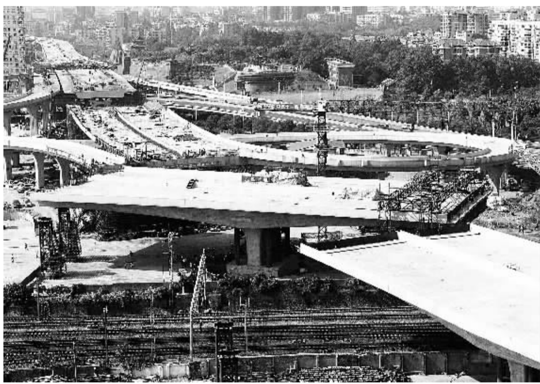
10月24日,武汉鹦鹉洲长江大桥跨京广铁路段进行“转体”施工。当日,武汉鹦鹉洲长江大桥南岸接线上,跨京广铁路箱式转体桥在京广铁路大动脉上空完成“转体”,与其余桥体顺利合龙。
