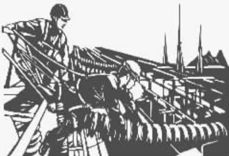
变电站里高压危
