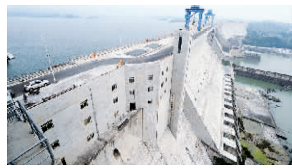
据长江水利委员会水文局实时数据显示，10月17日14时南水北调中线工程水源地丹江口水库水位达到160.08米，突破历史最高水位。图为俯瞰蓄水中的丹江口大坝及上游水库水面(10月17日摄)。
