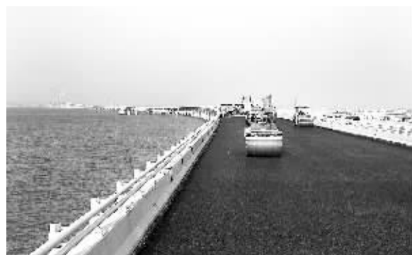
10月13日,施工人员在泉州湾跨海大桥上铺设沥青。泉州湾跨海大桥是经国家批准立项建设的高速公路项目,项目全长26.7公里,预计2015年上半年通车。
