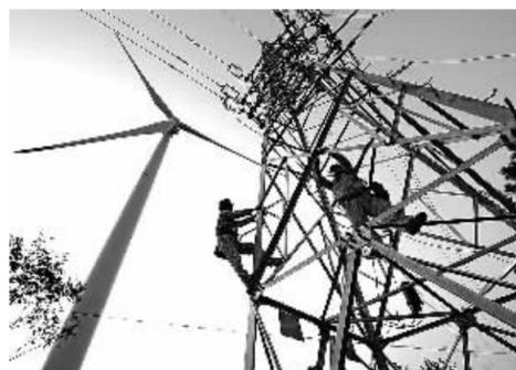
2014年9月10日,安徽省来安电力工程技术人员正在大唐来安唐龙风电场维护输电线路。该风电场是大唐新能源公司在安徽地区自主建成的首个风电场,装机总容量为4.8万千瓦,每年可为安徽电网提供清洁能源电量8700余万千瓦时,节省燃煤3万余吨。目前,一期工程安装24台单机容量为2000千瓦风力发电机组,实发电量502万千瓦时。(徐斌)
