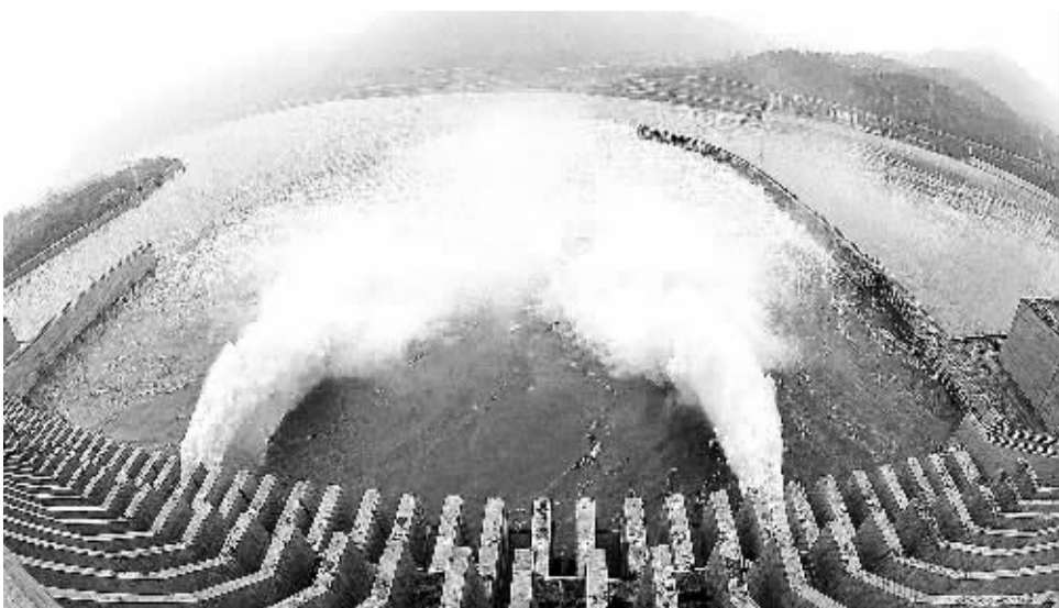
9月14日，长江水通过三峡大坝泄洪深孔下泄。14日14时，新一轮洪水过境，三峡枢纽的入库流量已达44500立方米每秒，水库水位创今年汛期新高，为此，三峡大坝开启泄洪深孔泄洪。按照国家防汛抗旱总指挥部的批复，三峡枢纽工程将于9月15日启动新一轮175米试验性蓄水。 郑家裕摄(新华社发)
