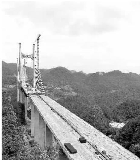
8月24日,工人在湖北恩施高速公路建河特大桥上铺装路面。恩施、恩施高速公路全长约157公里,按4车道高速公路标准建设,全线有特大、大中桥梁136座,隧道22条,目前通车在即。杨顺丞摄(新华社发)
