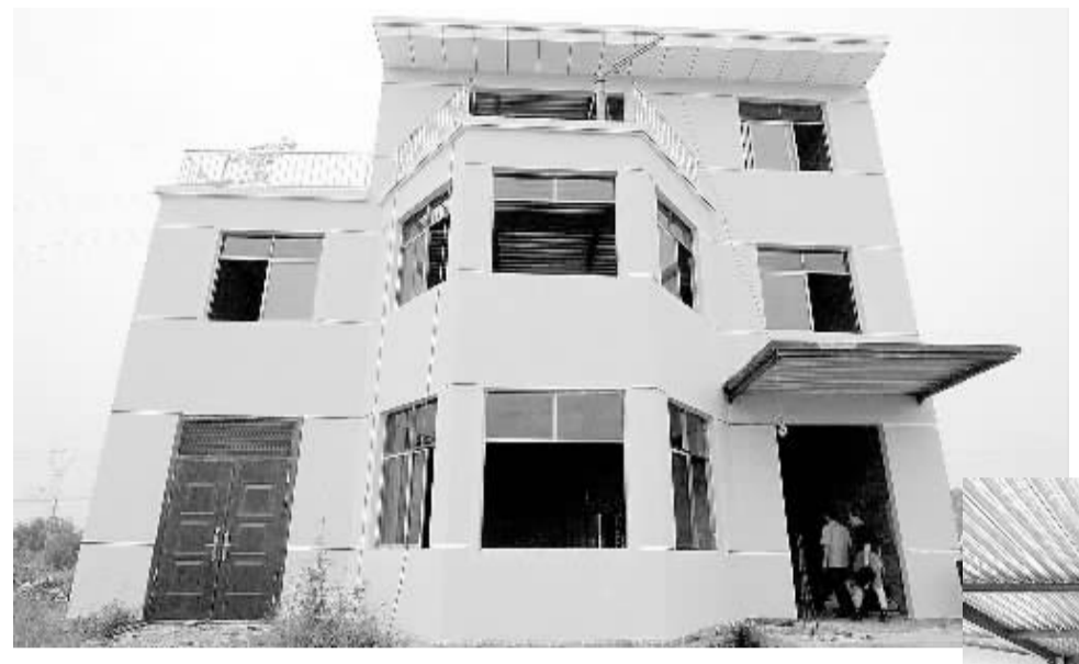
一体成型抗震房以钢结构为主,使用金属扩张网为免拆模板,以小U型钢为骨架作建筑物外墙,施工时整栋建筑物一次浇筑完成,具有较强的抗震效果。
