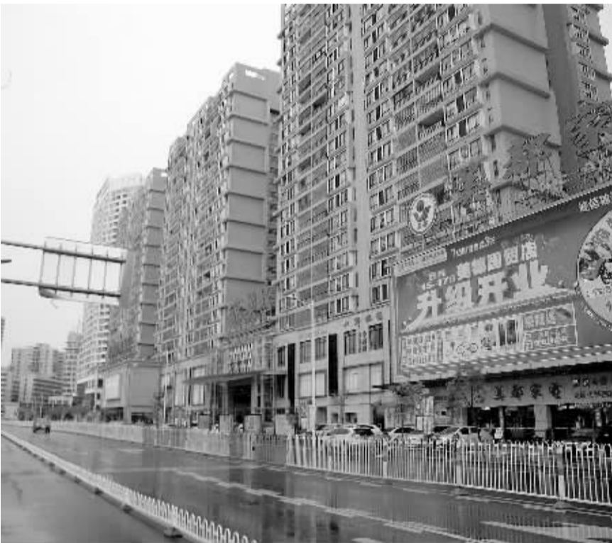
图为改造后的海南海口玉沙村。
