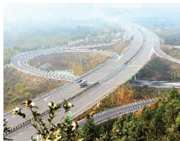
大广高速赣粤段全南枢纽。
