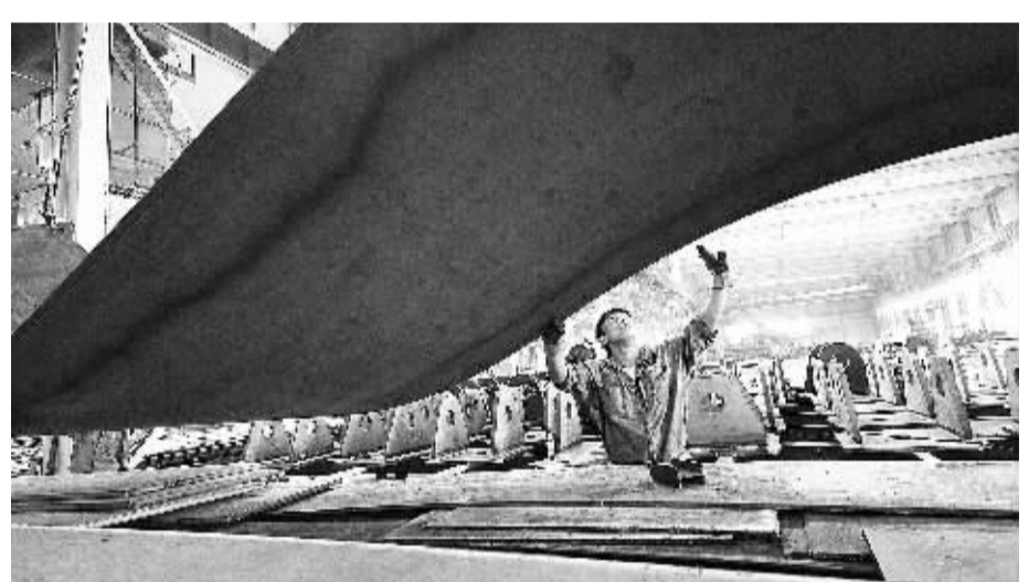
曹妃甸的发展离不开千千万万的建设者。图为华电重工工人正在工作。
