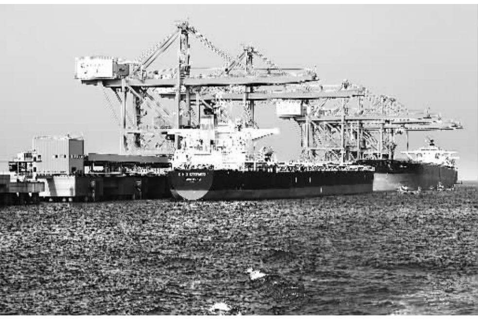
图为曹妃甸矿石码头。
