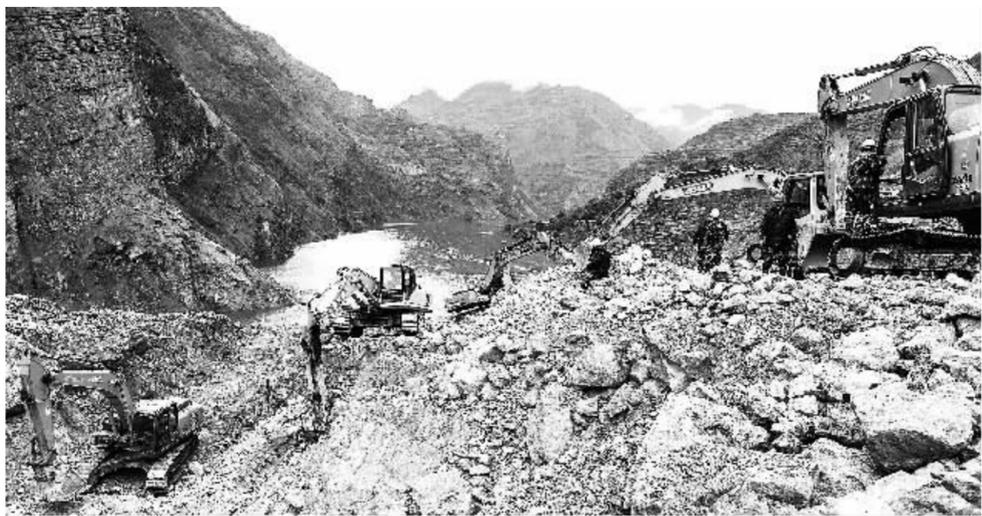
8月12日，武警水电部队冒着危险继续针对牛栏江堰塞湖堰塞体开展排险作业。当日，工程人员在牛栏江堰塞湖针对堰塞体上端挖开的泄流槽开展抢通作业，逐步排除连日降雨导致水位上升带来的安全隐患。
