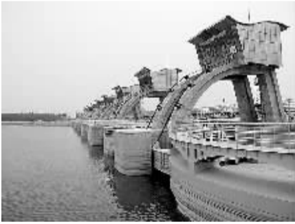
位于即墨移风店镇河段的九孔护目桥型拦河坝，是目前亚洲最大的同类型闸坝。
