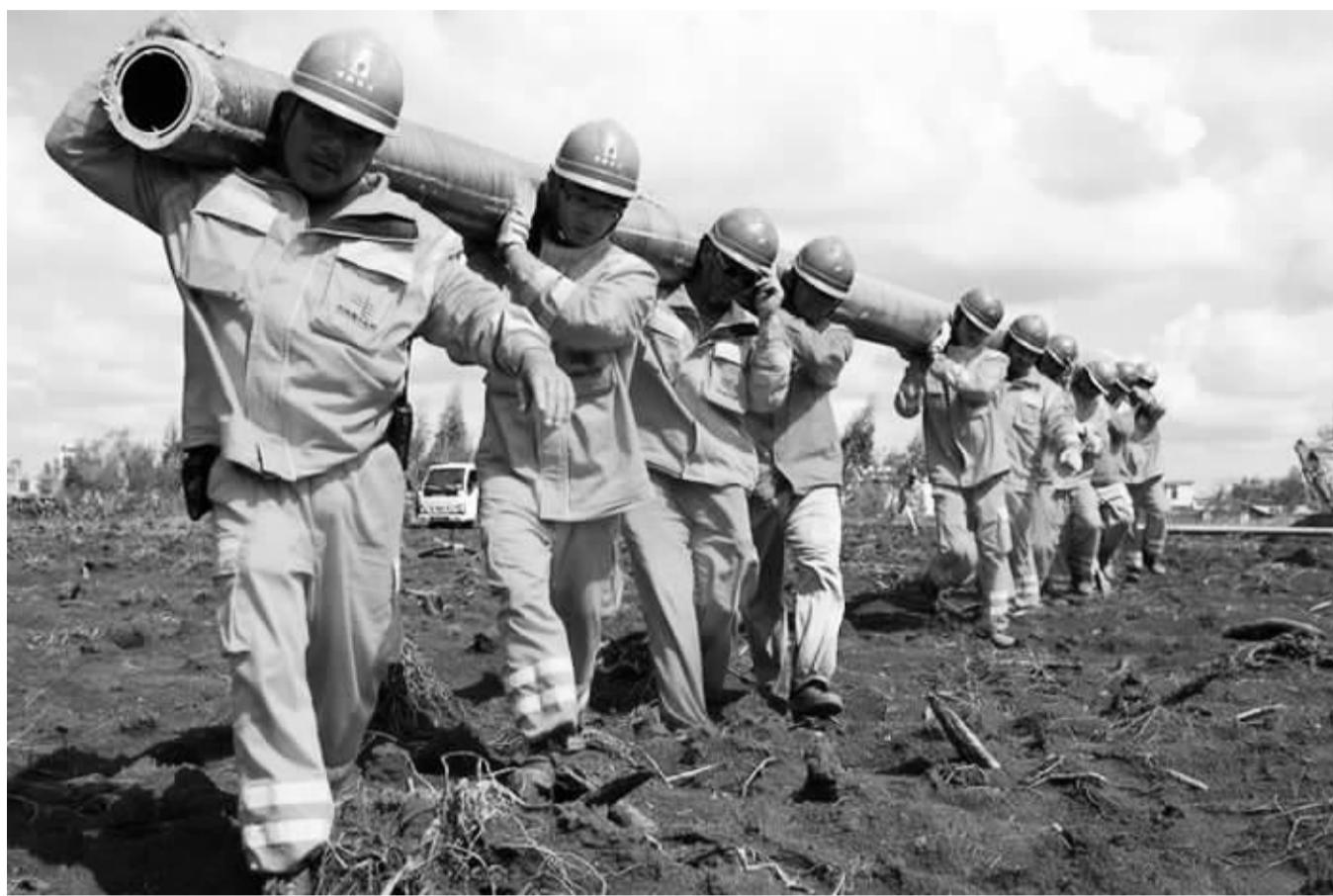
图为南网员工上下一心抢修复电。温永植摄
