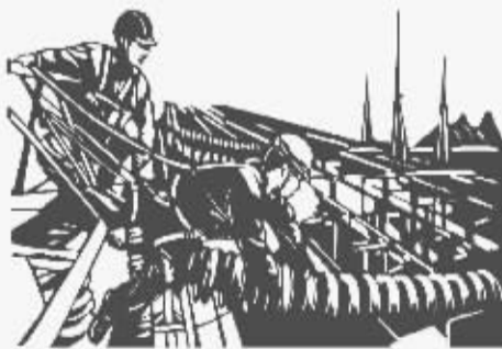
变电站里高压危
