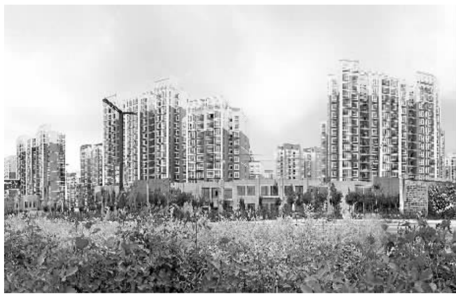
正在建设中的兰州新区一角。
