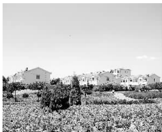
河北省永清县韩村镇九兴区是由8个村街通过撤村并居兴建的新农民社区,占地949亩。目前3个村街的农民已搬入新社区。
