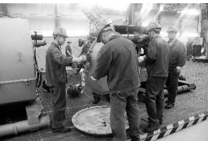
6月25日,陕西宝鸡石油机械公司泵业设备厂工人在安装钻井泵。本报记者 杨忠阳摄
