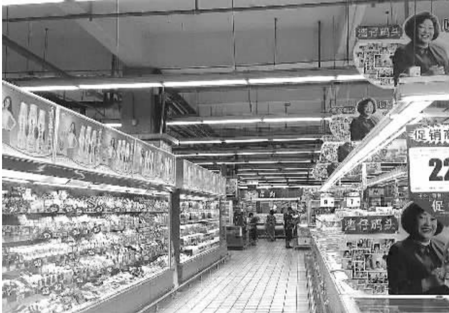
图为已经安装LED灯具的杭州世纪联华超市华商店店面。 本报记者 黄平摄
