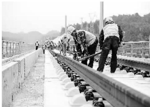
贵广高铁贵州境内210公里长的无砟轨道日前铺设完毕,为贵广高铁8月1日全线联调联试奠定了基础。贵广高铁是我国西部地区建设的第一条时速超过250公里的高速铁路。图为工人正在进行轨枕作业。
