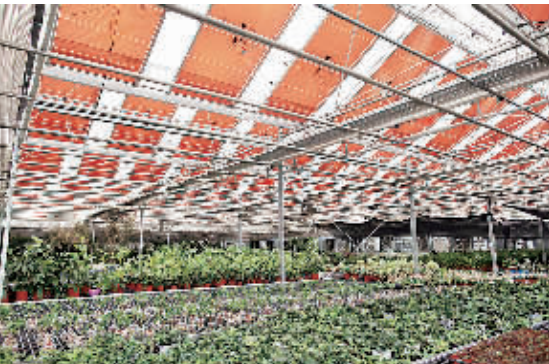
图为江苏省常州市武进区嘉泽镇花都产业园区的光伏太阳能大棚。该园区6个大棚屋顶上搭建有红色薄膜太阳能板,光线照射后,薄膜通过光电效应产生电流,送出“绿色电能”。 孙 宇摄(新华社发)
