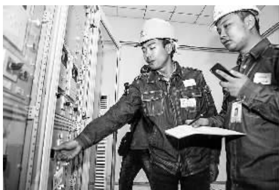
5月12日,中国铁建电气化局集团一公司技术人员在乌鲁木齐供电段一铁路牵引变电所里进行通电工作。当日,乌鲁木齐动车运用所正式送电,此举拉开兰新铁路第二双线全线送电序幕。 新华社记者 赵戈摄
