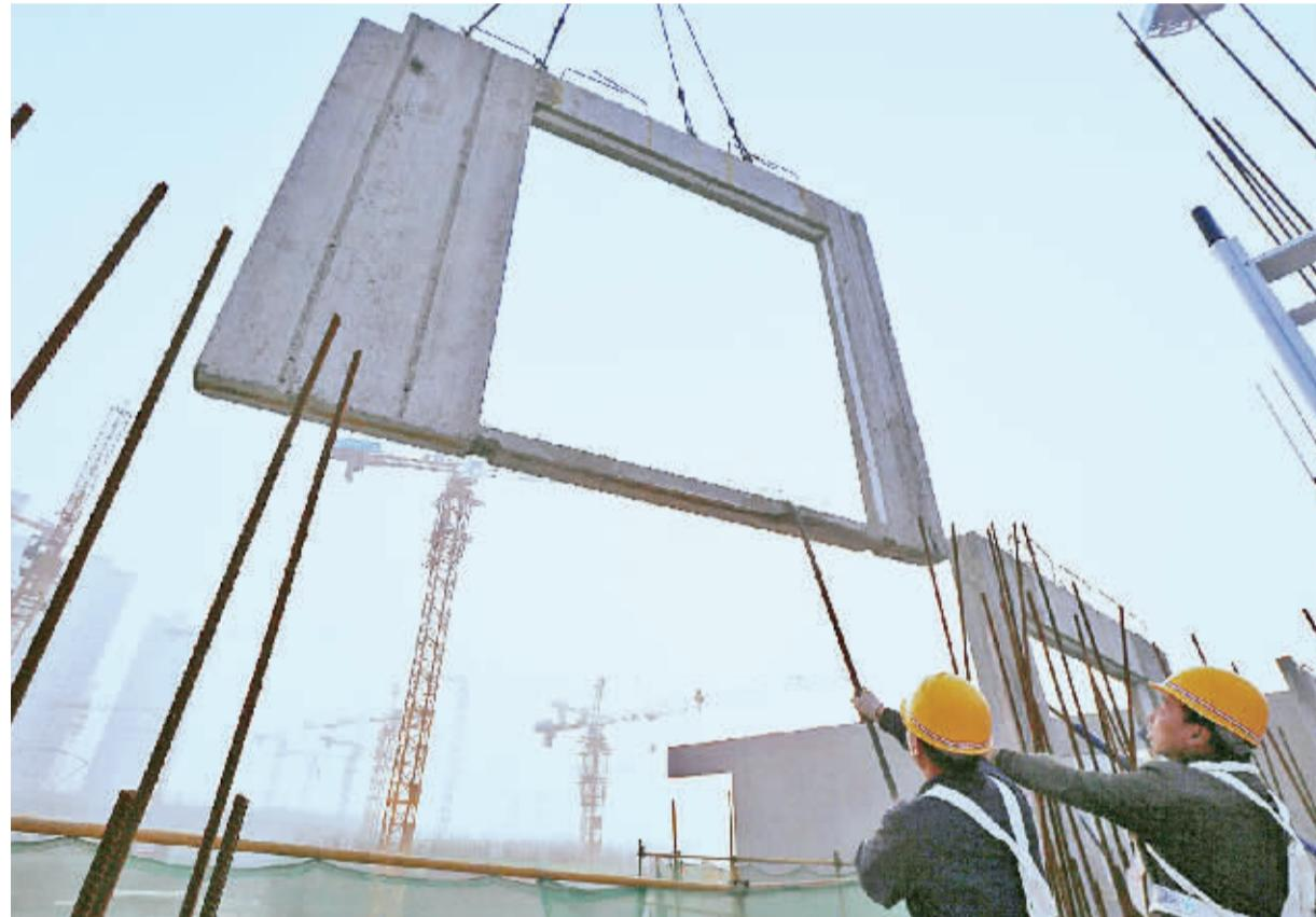
图为工人正在装配合肥中科大先进技术研究院人才公寓。据了解，该建筑占地5万平方米，采用产业化建筑方式后，该工程只用了86天就实现结构封顶。
