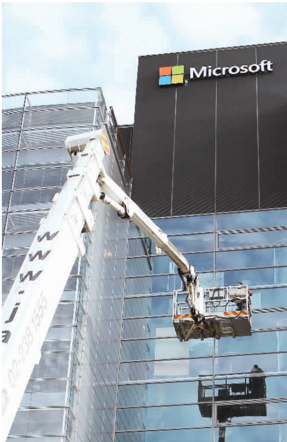
4月26日，在芬兰埃斯波市，工人在原诺基亚总部大楼外墙安装微软的标志。芬兰通信公司诺基亚25日宣布完成向微软出售设备与服务部门的业务。至此，这项历时近8个月，总额达50多亿欧元的交易最终尘埃落定。 新华社发
