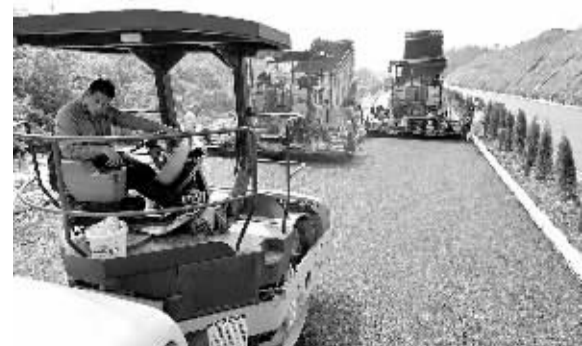
建设者在湖北省远安县境内的保宜高速公路铺设路面沥青。保宜高速公路是湖北省高速公路网规划中鄂西生态文化旅游圈规划的重点项目,将于2015年底全线通车。 新华社记者 杜华举摄
