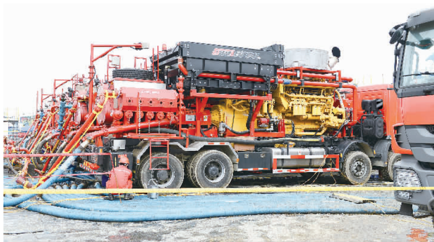
图为江汉井下测试公司“井工厂”压裂试气施工现场。
