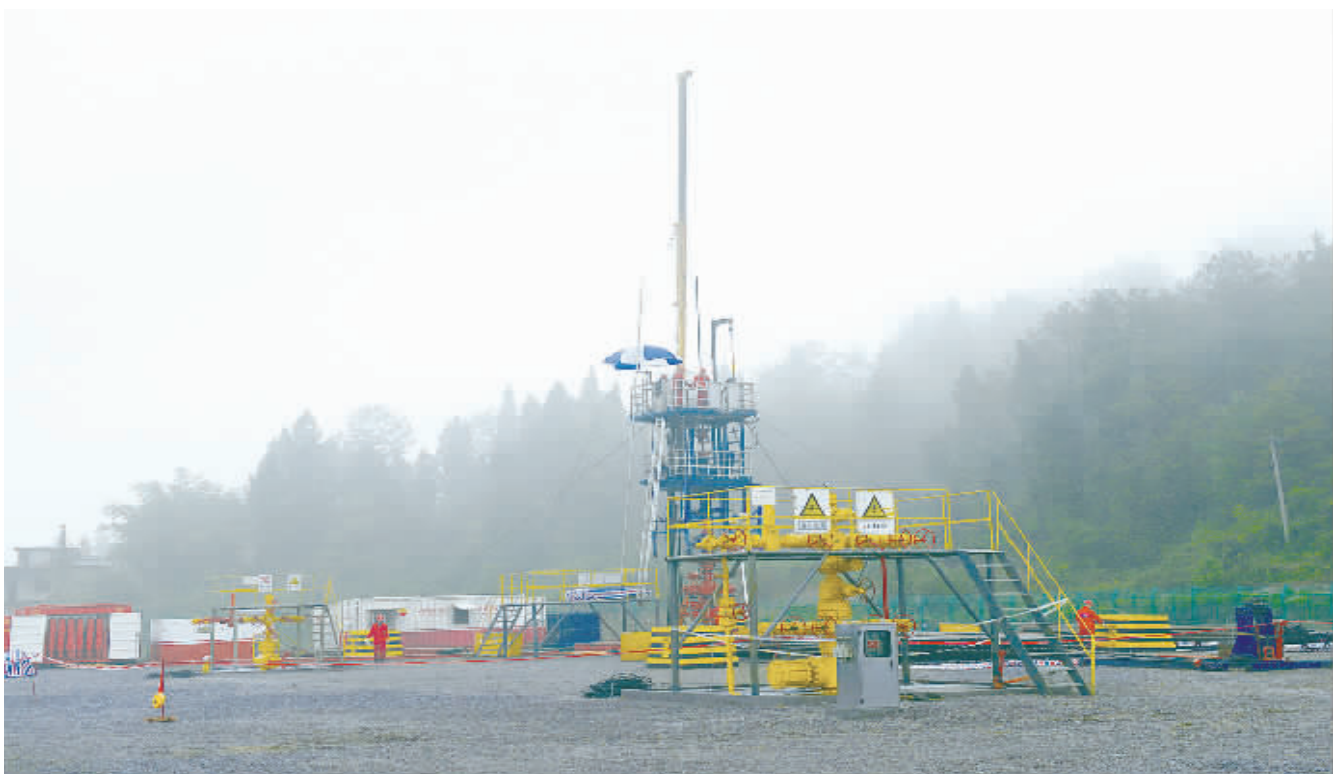
涪陵页岩气田中石化焦页1HF井。该井是国内第一口实现规模化、商业化开发的页岩气井。重庆市政府于4月9日将其正式命名为“页岩气开发功勋井”。
